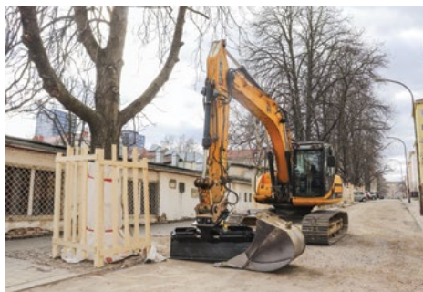
Obr. 46: Ochrana kmene bedněním (foto: autoři)
