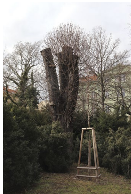
Obr. 60: Řez na bezpečné torzo (foto: autoři)
